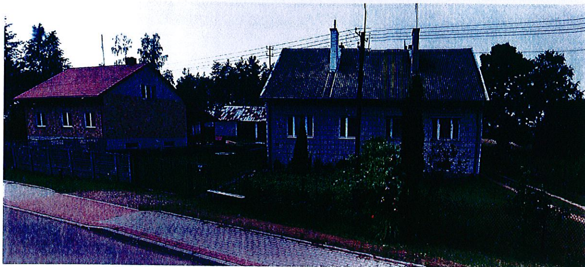
Fot. Przykład niedocieplonych domów w miejscowości Kuskowo
